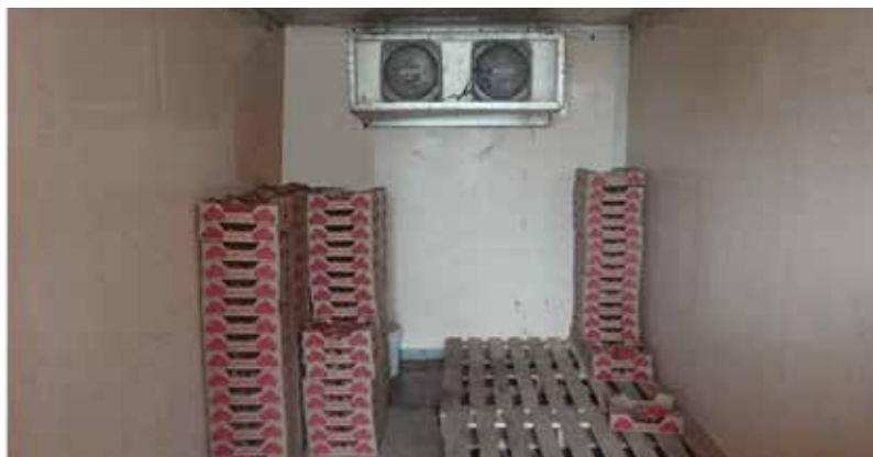
Foto 10 – Câmara fria com caixas de morango estocadas
