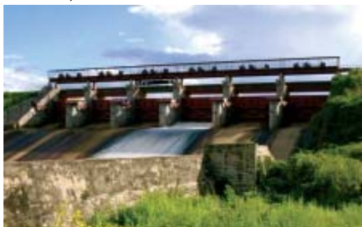
FOTO 4 – AÇUDE BANABUIÚ – BANABUIÚ – CE, 2004
