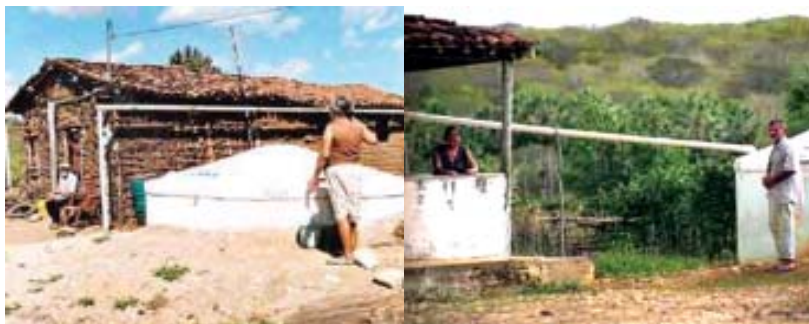
FOTOS 1 E 2 – CISTERNAS EM CASAS ISOLADAS NO SERTÃO
