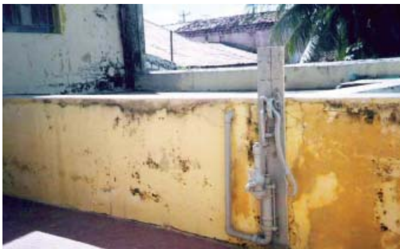
FOTO 2 – BOMBA MANUAL USADA EM CISTERNA CONSTRUÍDA EM CASA DO SERTÃO.
